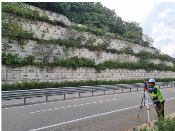
광파기를 이용한 측량 작업
